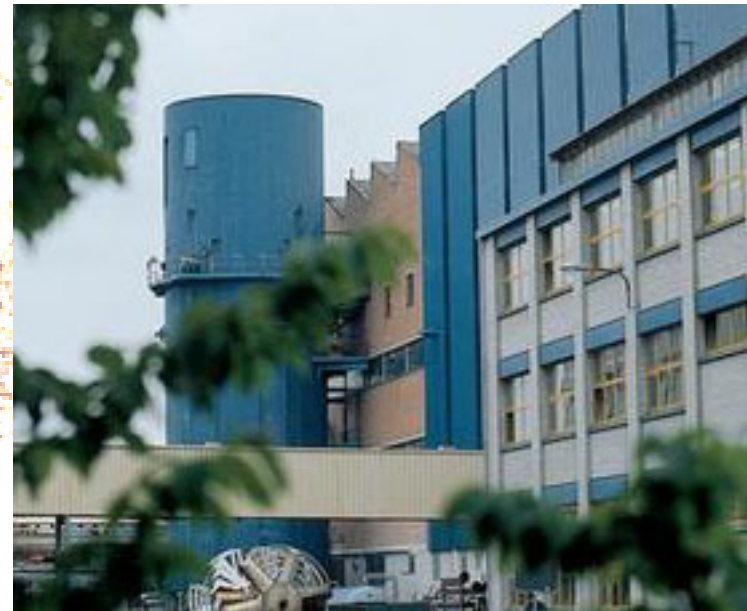
Les cossettes passent dans la tour d'extraction pour obtenir le jus vert
